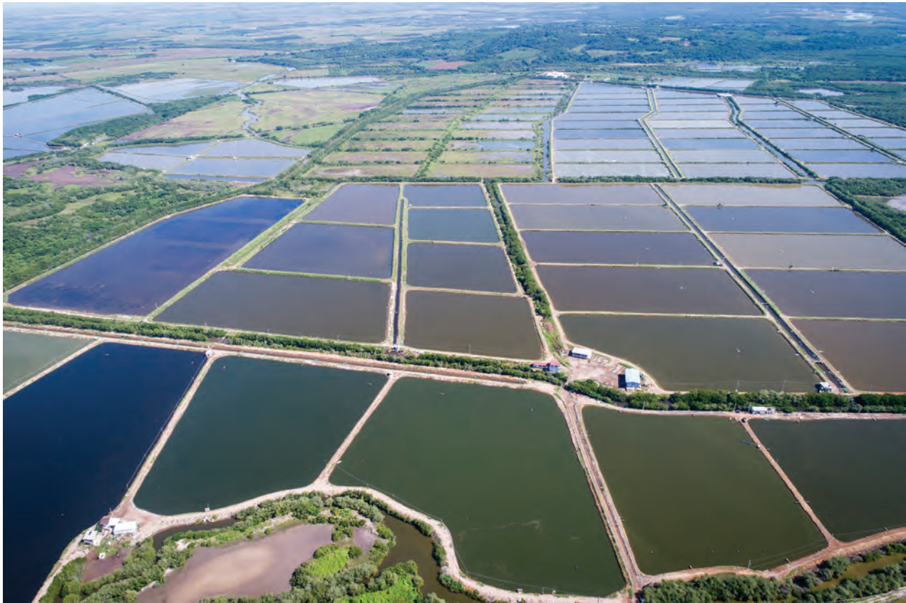
Es urgente la instalación de lagunas de oxidación en las granjas camaronícolas para disminuir la contaminación por descargas de aguas residuales al sistema lagunar. Foto: © The Nature Conservancy/Carlos Aguilera
